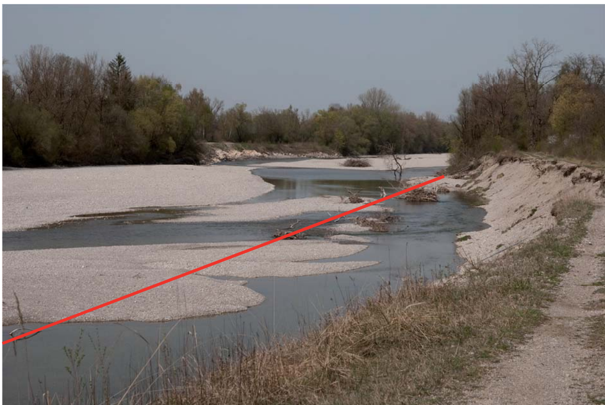
Abbildung 2.1 Lech – Uferanbruch bei Fkm 33,5 – ehemaliger Böschungsfuß (rot)
